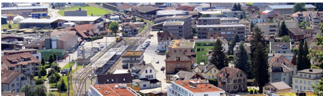
Abb. 4: Blick auf den Bahnhof
