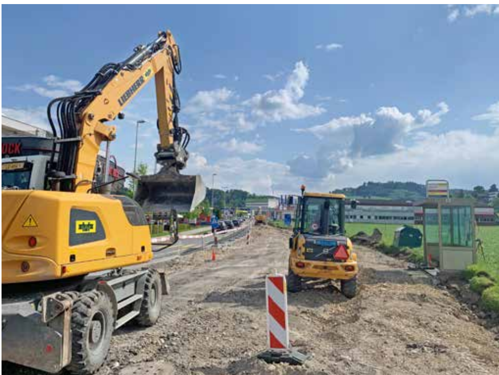
Die Bauarbeiten auf der Kantonsstrasse sind in vollem Gange.
