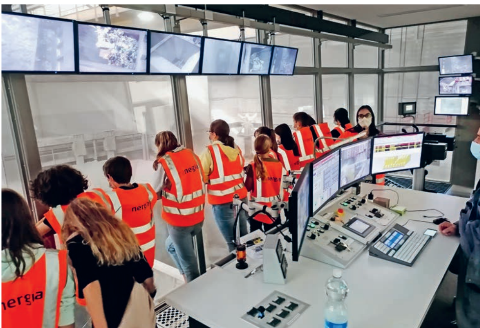
Blick hinunter in den Abfallbunker der Renergia.
