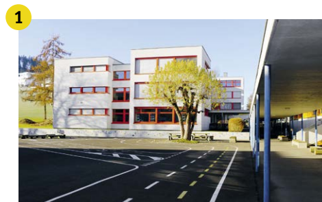
1967: Schulhaus Schlossfeld, Trakt C
